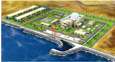
SMART (Korea), 100 MW, Betrieb in Saudi-Arabien ab 2026
