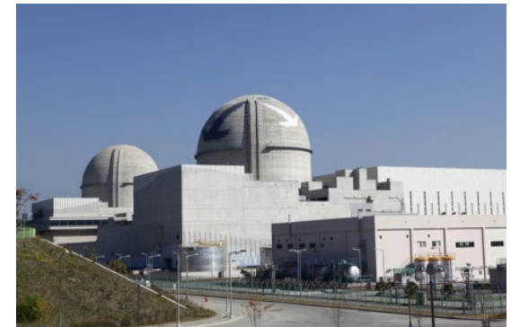
APR-1400 (KEPCO) in Barakah (UAE), 1400 MW
