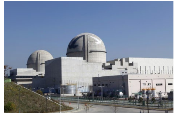
APR-1400 (KEPCO) in Barakah (UAE), 1400 MW
